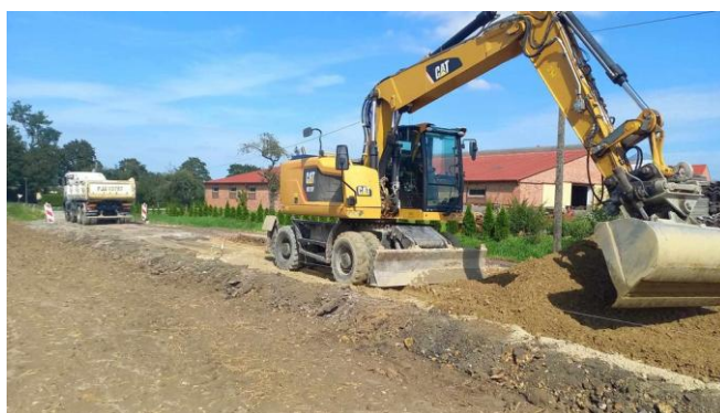
Budowa drogi w Tatarach
