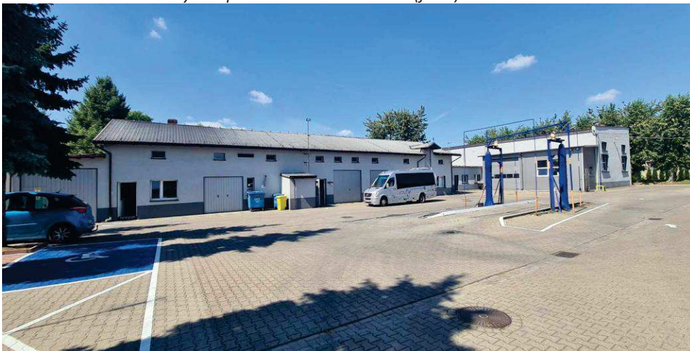
Fotografia 2. Baza MZK w Krotoszynie Sp. z o.o. – ul. Kobierska 5 (fot.2)
