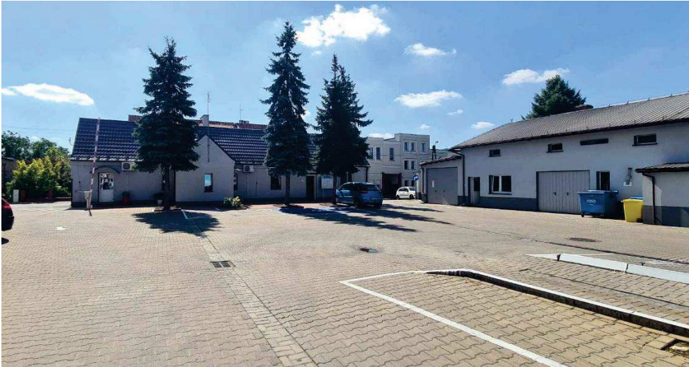
Fotografia 1. Baza MZK w Krotoszynie Sp. z o.o. – ul. Kobierska 5 (fot.1)
